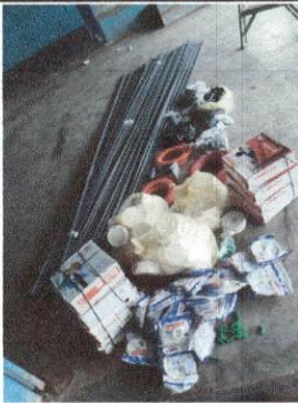
FOTO5: Material que se compro para remozamiento
